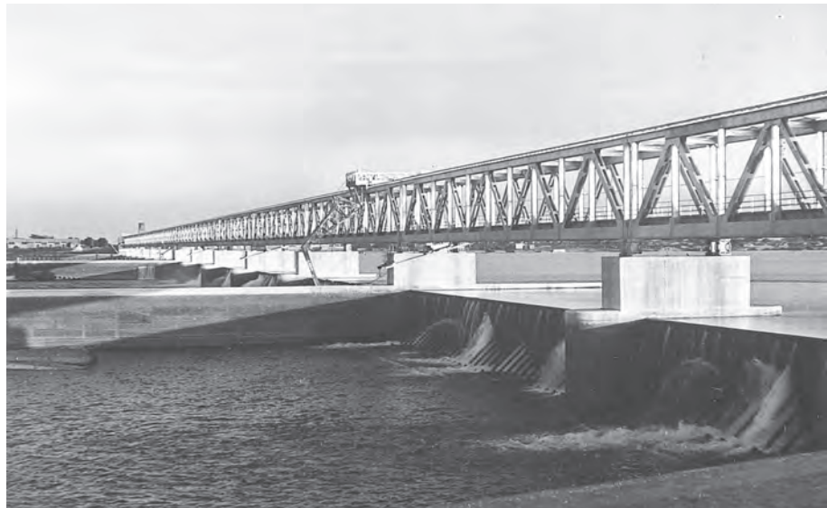
Staudamm über den Fluss Niger in Markala
